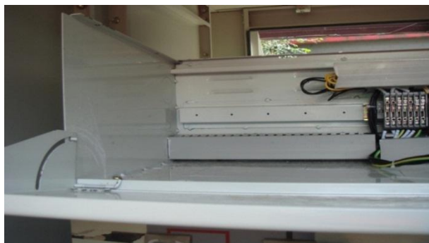
图 7-4 环网柜仪表室顶盖做成斜坡并加装导水槽
